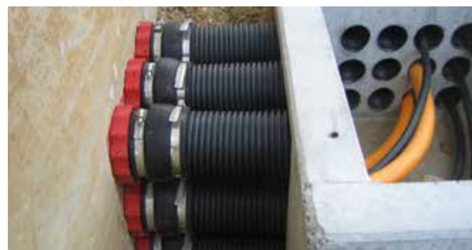
Geribde buisaansluiting via manchette techniek HSI 150-M 168
