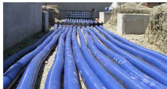
Flexibele kabeldoorvoersysteem - onbeperkt verlengbaar
