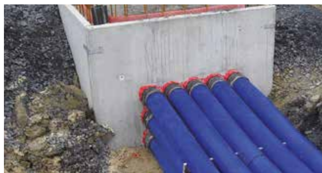
KES-M 90-D – aansluiting aan dichtpakking HSI 90
