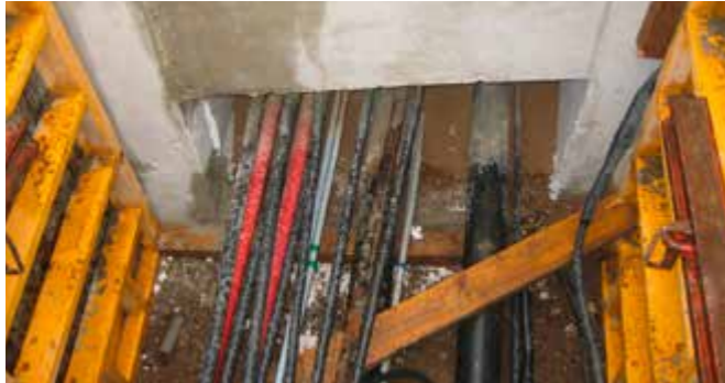
Ter plaatse aanwezige rechthoekige uitsparing – moet naderhand worden afgedicht
