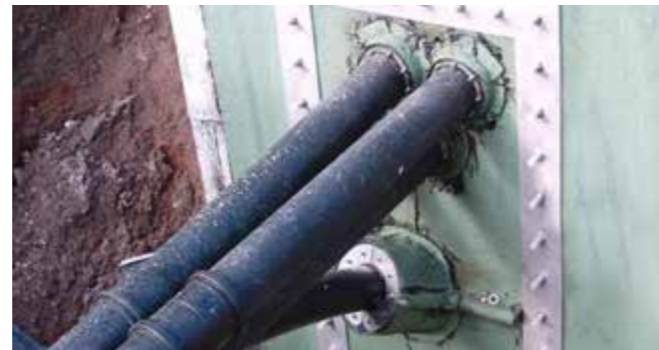
Gesplitste vaste/losse flens op basis van DIN 18195
