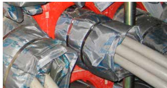
HSS – inbouw van brandbeveiligingskussens in instortpakking HSI 150-K2. Afdichting met systeemdeksel of Segmento
