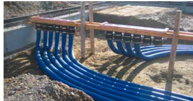
Bodemdoorvoer met KES-systeem met de door de klant geleverde hulpconstructie (buigradius min. 1m)
