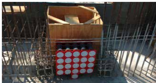
Inbouw van dubbele instortpakking HSI 90-K2 in bekistingsnet voor inbetonneren
