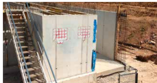
HSI 90-K2 na het inbetonneren: hier volgt de lege buisverbinding
