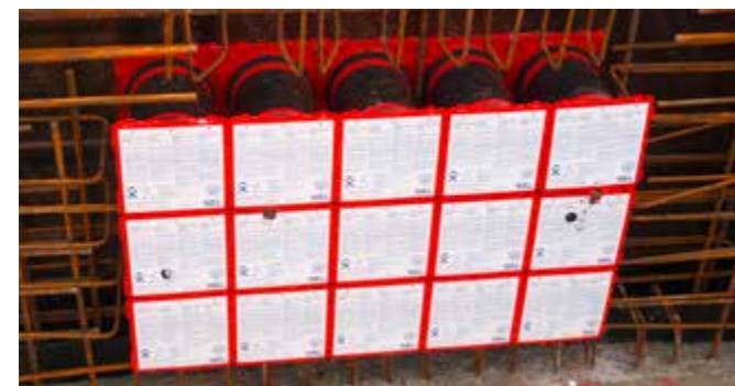
Dubbele dichtpakking HSI150 als pakket in bekisting geplaatst
