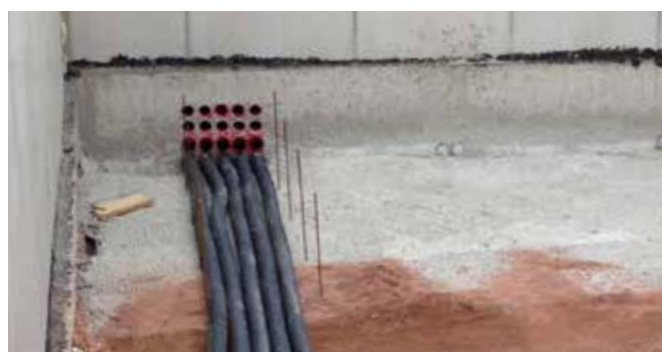
Geribde buisaansluiting HSI 90-D75 KS
