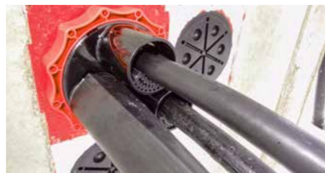
Centreerband in tuiten van systeemdeksel HSI150-D3/58
