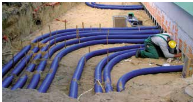
Drukdicte aansluiting van Hateflex 14150 op HSI 150 instortpakking
