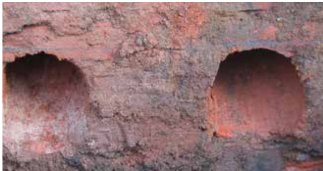
Schuine boring in poreus metselwerk
