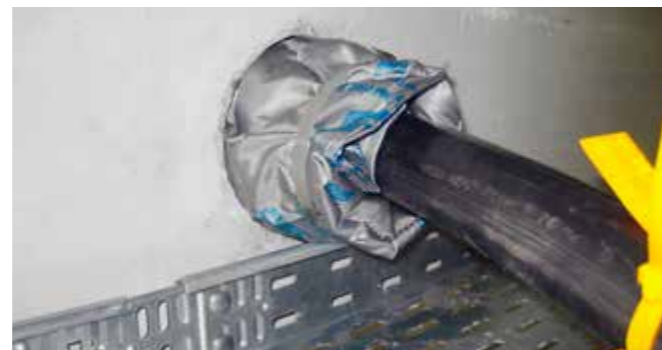
HSS – inbouw in kernboringen met HRD rubberafdichtingen
