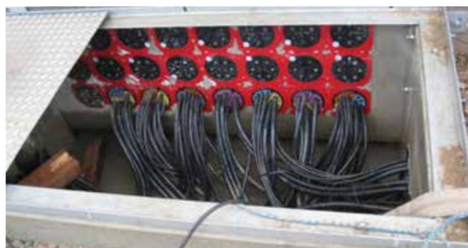
HSI 150 - doorvoer uitgerust met SEGMENTO afdichtstelsysteem voor stuurkabels in een schakelhuis
