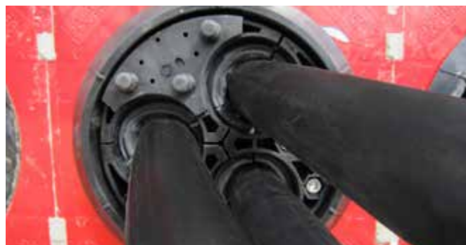
Drukplaatafdichting HSI 150-PA-3/24-54
