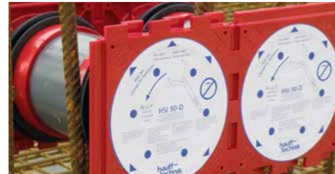
Dubbele instortpakking HSI 90 als pakket in bekisting ingezet
