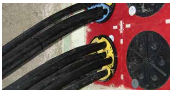
Afdichting van kabels voor straatverlichting met SEGMENTO
