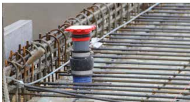
KES-M 90-KVB – inbouw in bodemplaat
