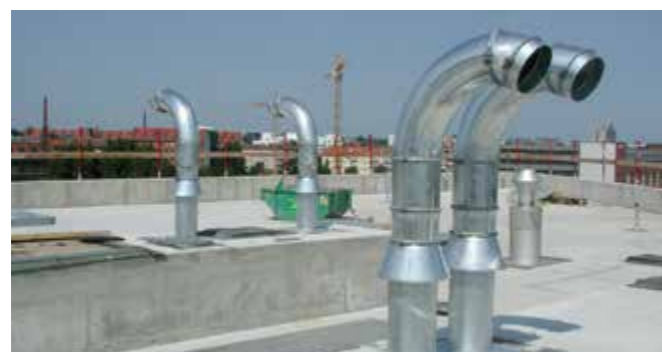
Gemonteerde SHD 200 voor verlegging van dakafdichting
