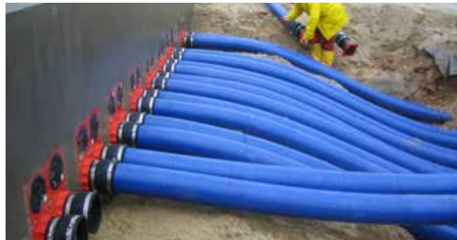
Drukdicte aansluiting van Hateflexbuizen 14150 op HSI150 instortpakking
