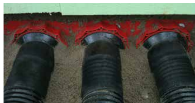
Geribde buisaansluiting met koude krimp techniek HSI 150-D 110-KS
