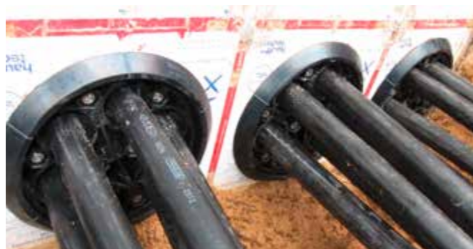
Afdichting van laagspanningskabels met HSI150-DG-6/10-36
