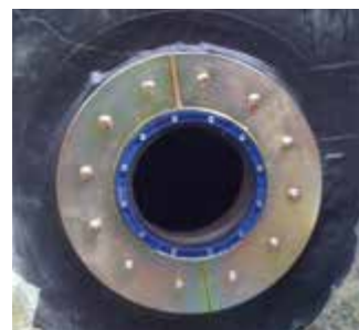
HSD-C 200/159 in verzinkte vaste en losse flens
