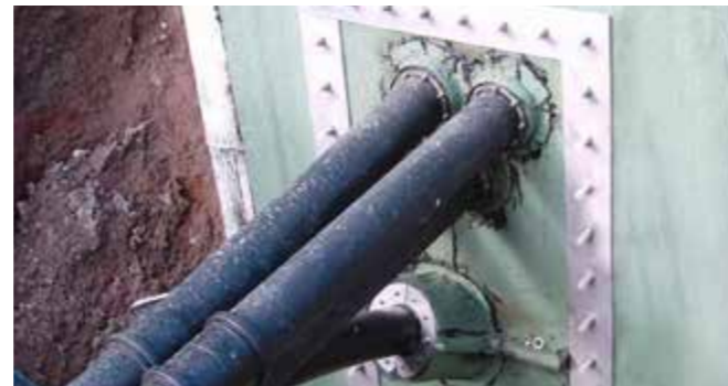
Gesplitste vaste/losse flens op basis van DIN 18195
