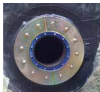
HRD 300-FUF/300-vz met de standaard drukdichting HSD-C (gepoedercoat)
