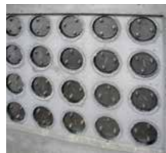
FZR 100/240 afdichting buistraject
