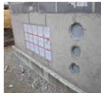
ZVR 150/300 en ZVR 200/300 ingebed in beton naast HSI 150
