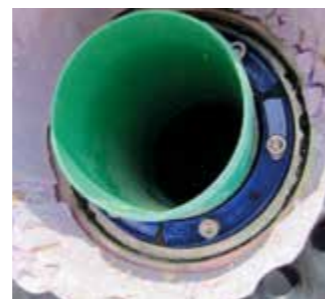
HSD-C 150/110 in verzinkte vaste en losse flens
