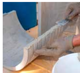
FZR-G 350/300 met plamuur van montageset Z-FZR-G
