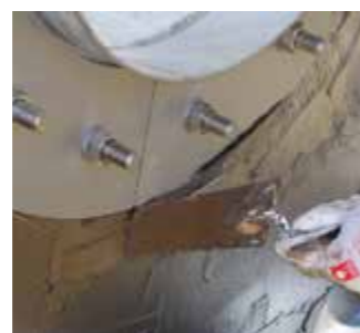
HRD 300-FUF/300 roestvrijstaalen uitvoering met aansluiting op KMB middels vliesaanvulling, zie pagina 37
