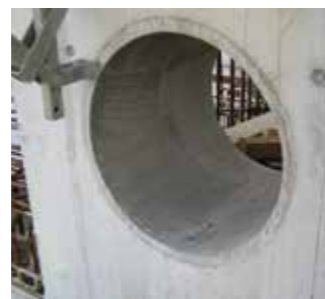
FZR 400/300 inbouwlocatie zuiveringsinstallatie
