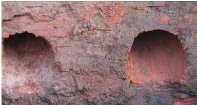
Schuine boring in poreus metselwerk
