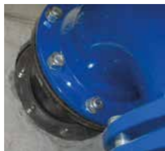
HRD 250-1G-1/210 aansluiting hoofdleiding water
