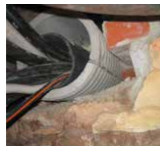
FZR-G 150/350 sanering in het metselwerk
